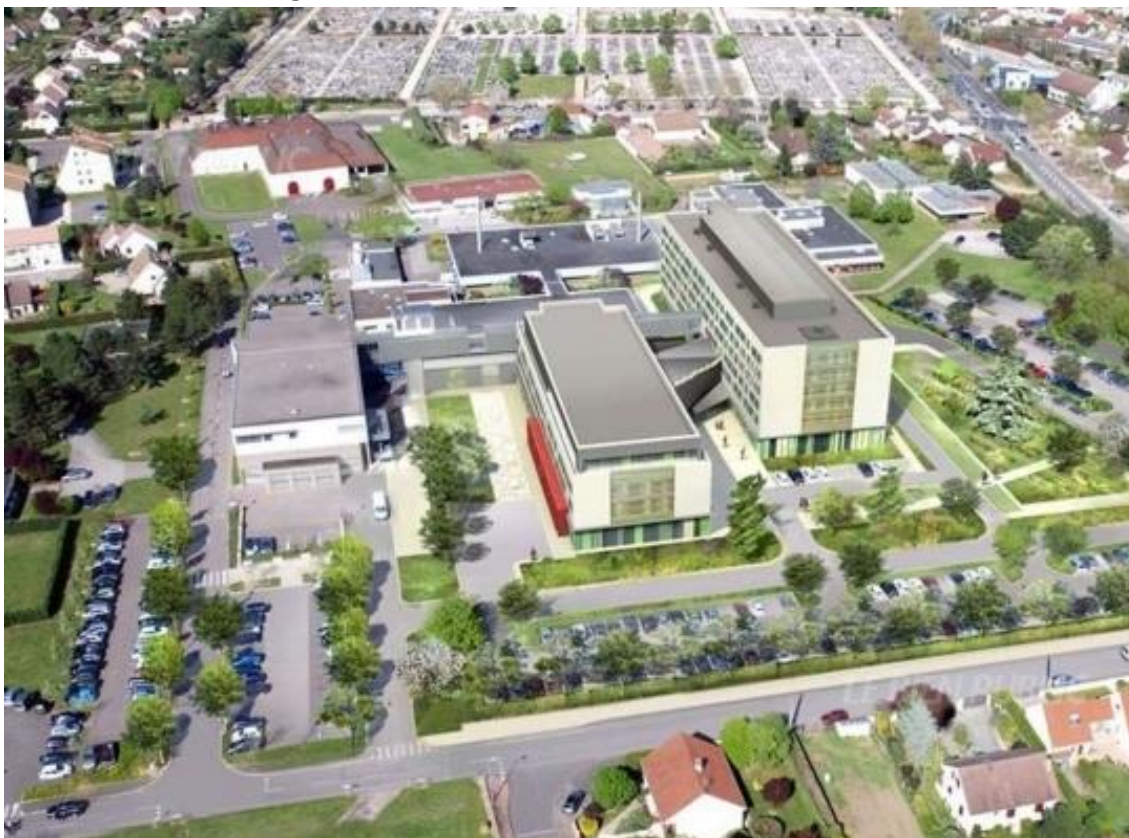
La vue aérienne du projet
